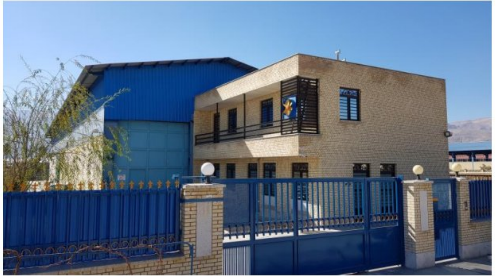
ورودی کارگاه تولید
