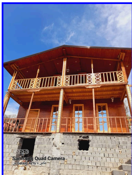
ساختمان دو طبقه چوبی 128 متر تمام چوب اجرا شده در مازندران سوادکوه اجرای کامل متری 10 میلیون تومان
